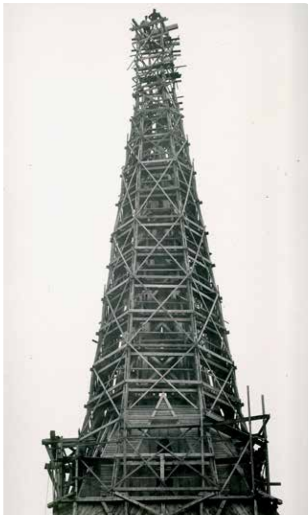
Et sjældent billede fra arbejdet med at rejse spiret i 1898, læg mærke til de to arbejdere øverst oppe i spiret. Foto kirkens arkiv.
